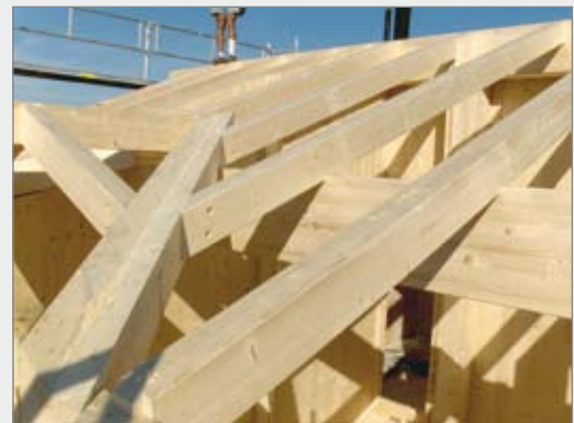
spojení hlavního nosníku s trámy pomocí řezných vrtů HBS
