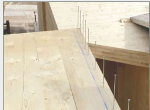
spojení stropu a stěny u dřevěné stavby
